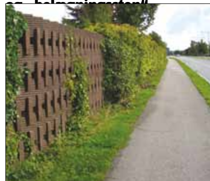
Støjmur. Muren er lavet åben for at kunne beplante den og for at reducere den støj, der reflekteres til den anden side af vejen.
