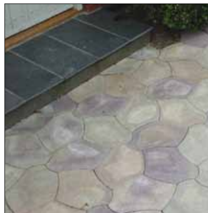
Kalkudfældninger er almindelige, og forsvinder igen i løbet af 1-2 år.
