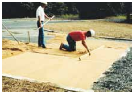
Afretningen kan foretages med et lige bræt og ledeskinner i form af jernrør, der lægges i afretningslaget.
