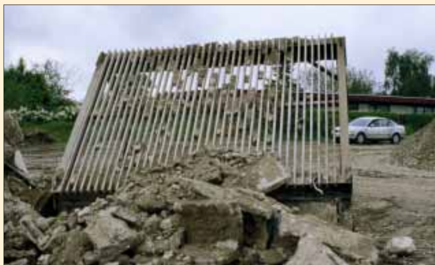
En del af den opgravede jord blev grovsorteret vha. en rist på depotplads tæt ved rørgraven.
