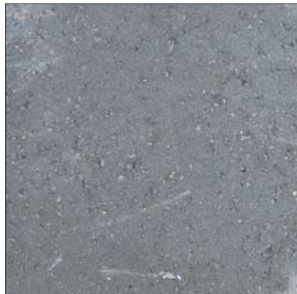
Varierende porestruktur kan give et udseende som dette, når fliserne tørrer ud efter regnvejr. Det er ikke tegn på manglende modstandsevne over for påvirkninger fra frost/tø og salt.
